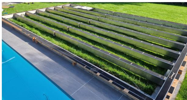
Alle Komponenten des Tragwerks, wie Rohrprofile, angeschweißte Teile, Schrauben und Muttern sind aus hochwertigem, nichtrostendem Edelstahl, um eine Abnahme der Festigkeit durch Korrosion zu verhindern. Durch die rechteckigen Rohrprofile wird eine maximale Steifigkeit bei einer Bauhöhe von insgesamt 19 cm (ohne Holzverkleidung) erreicht. Um die Durchbiegung der Träger zu verhindern, kön-
